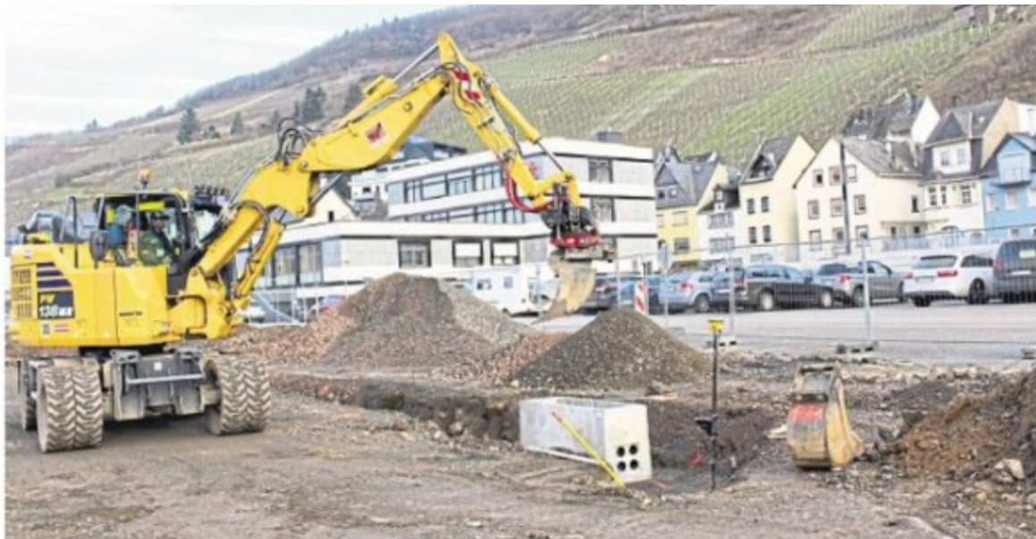
Zurzeit werden am Zeller Moselufer Leitungen verlegt, und der Rad- und Gehweg wird hergerichtet. Foto: Winfried Simon
