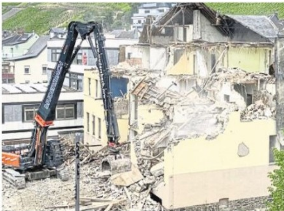
Derzeit wird das ehemalige Verwaltungsgebäude der Verbandsgemeinde Zell abgerissen.
