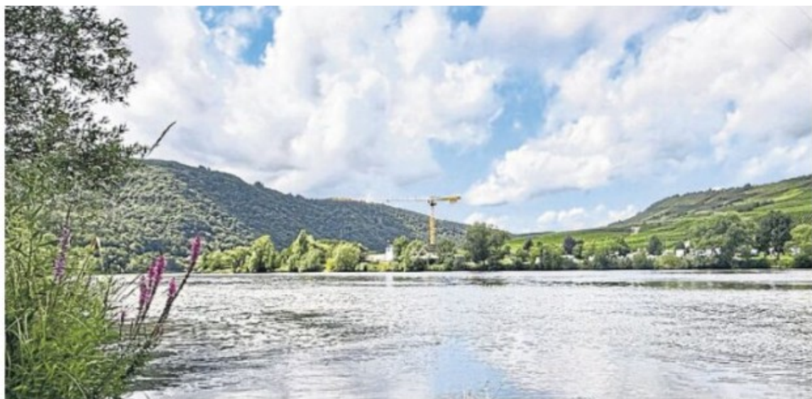
Bislang wird die Wärme aus Flüssen in Deutschland selten energetisch genutzt. Das wird sich in Zell nun ändern.
