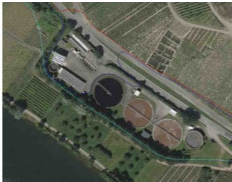
Die Kläranlage von oben
