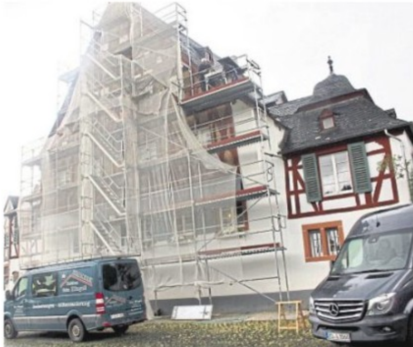
Es ist eines der schönsten Fachwerkhäuser an der Mosel. Zurzeit wird die prächtige Fassade des Boos von Waldeckhof in Zell-Kaimt saniert.
