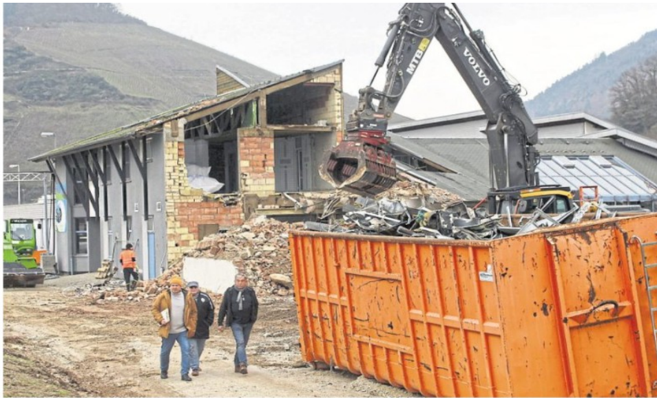
Die Abbrucharbeiten an dem alten Schwimmbad haben begonnen.
