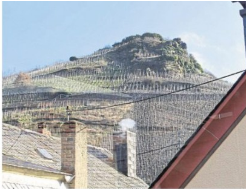
Der sogenannte Teufelsfelsen ist in Bewegung und wird mithilfe von Sensoren permanent überwacht.
