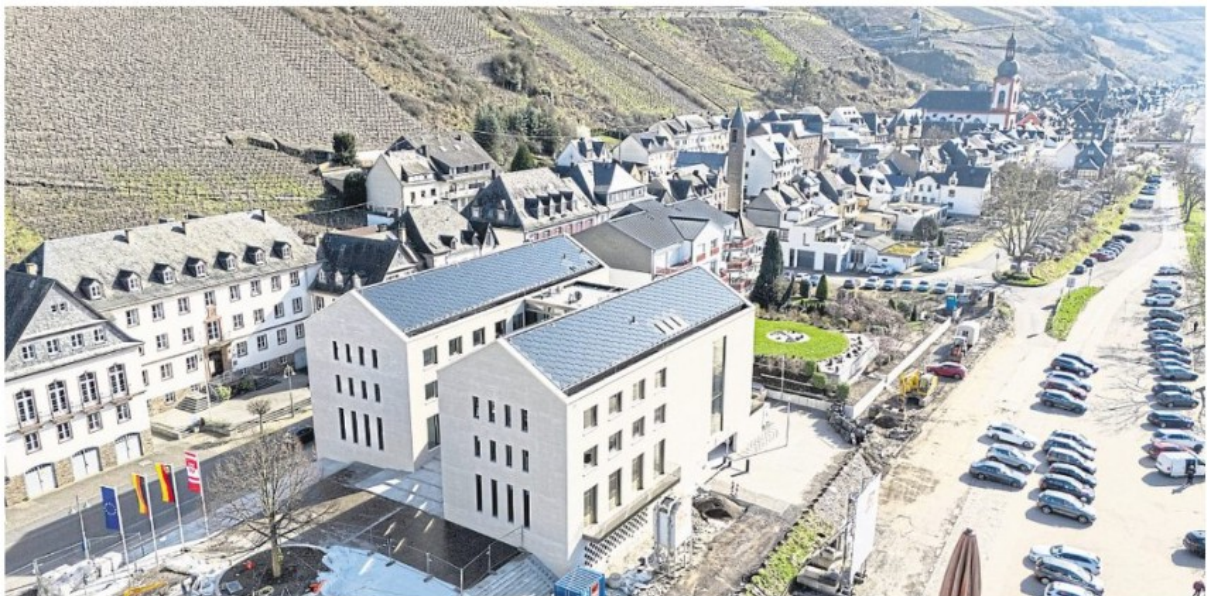
Nach rund drei Jahren Bauzeit ist das neue Rathaus der Verbandsgemeinde Zell offiziell eröffnet. Der Neubau an der Zeller Schloßstraße gegenüber dem Finanzamt ist ein wichtiges Puzzleteil im Gesamtkonzept der Moselstadt, ihren Uferabschnitt zwischen der Fußgängerbrücke und dem Corray entscheidend zu attraktivieren. Foto: Kevin Rühle
